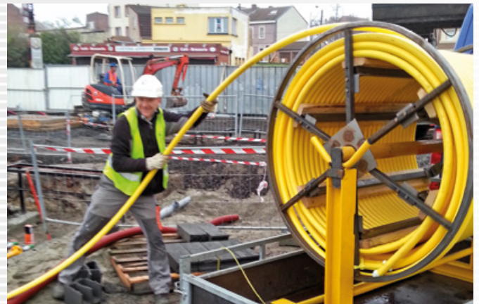
Installierung eines LPG-FLEX Rohrs
