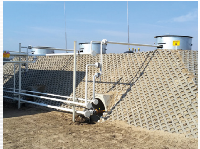
Projekt LPG-Gasabfüllanlage: 3 x 50 m 3 , Ø 2500 mm
