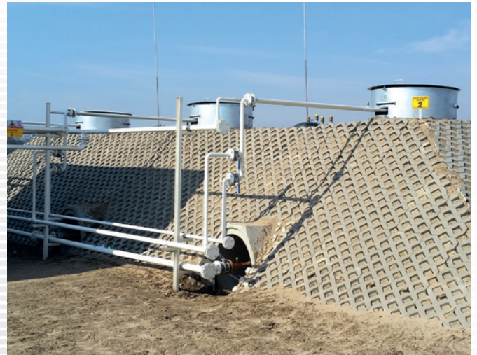
Projekt LPG-Gasabfüllanlage: 3 x 50 m 3 , Ø 2500 mm
