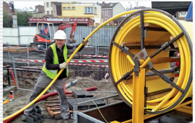
Installierung eines LPG-FLEX Rohrs
