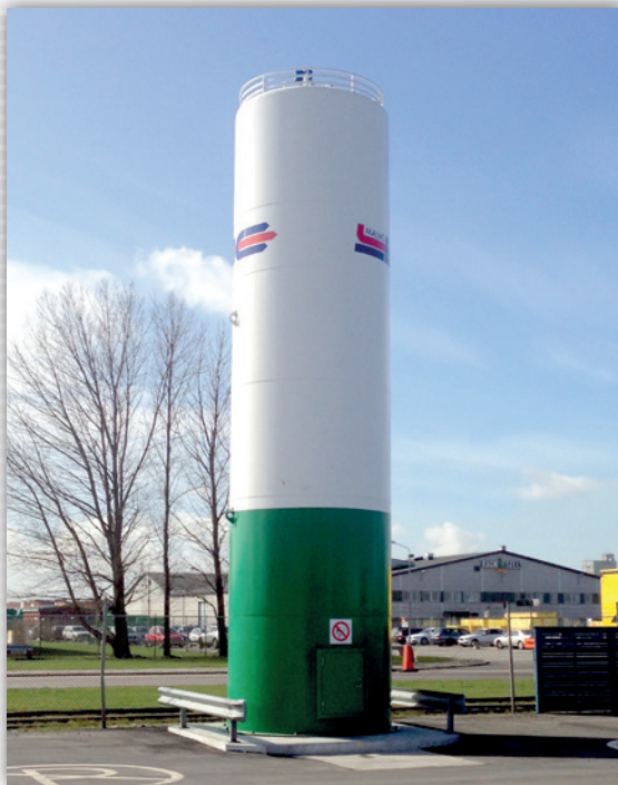
Standard-50 m 3 -Tank mit einem Durchmesser von 2500 mm
